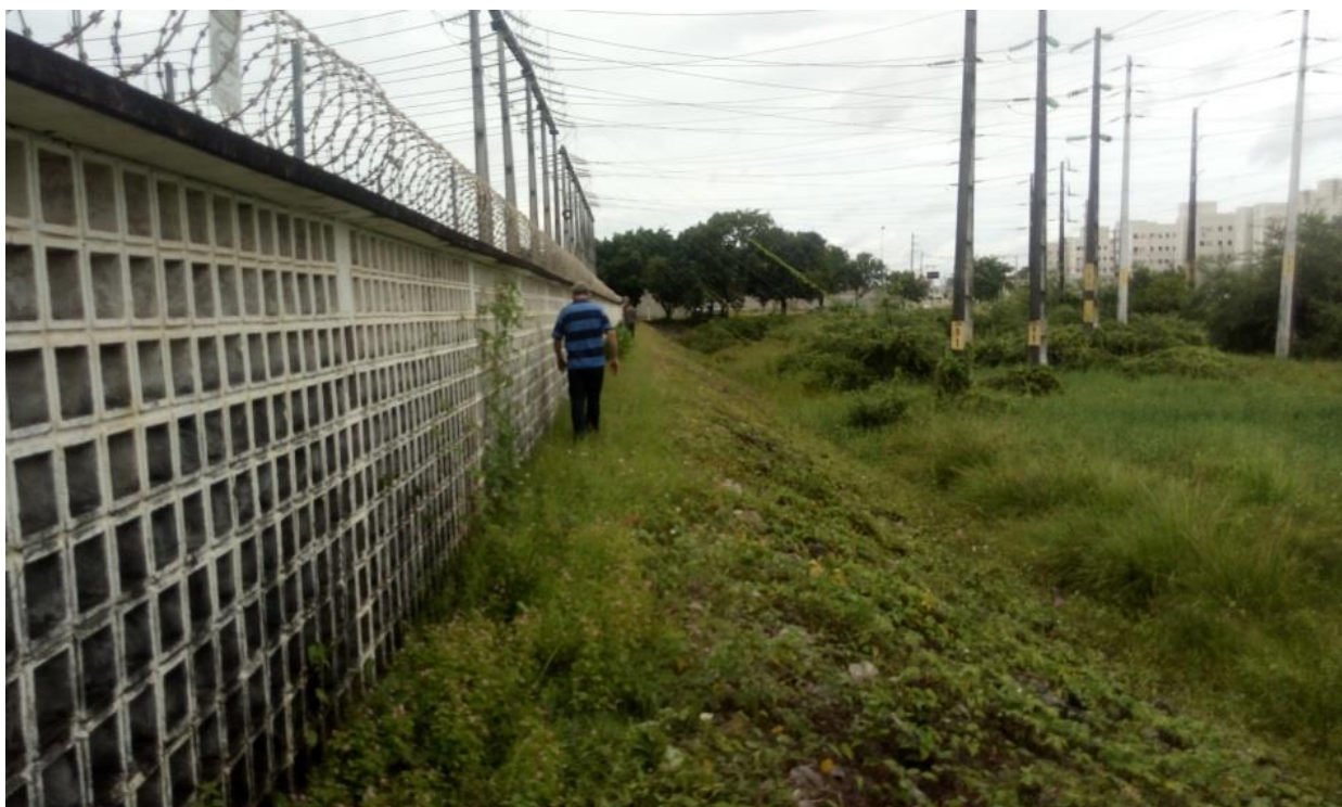
Figura 9 – Perfil do terreno da subestação existente Delmiro Gouveia – terreno alteado em função da proximidade com curso d’água
